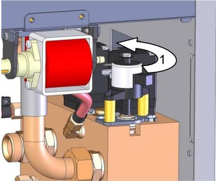
Abb. 79: Kühlventil 1 ausbauen
